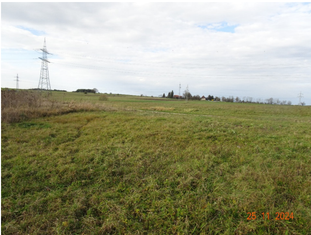
Foto 3: Blick in Richtung Norden, im Hintergrund mehrere Freileitungen
